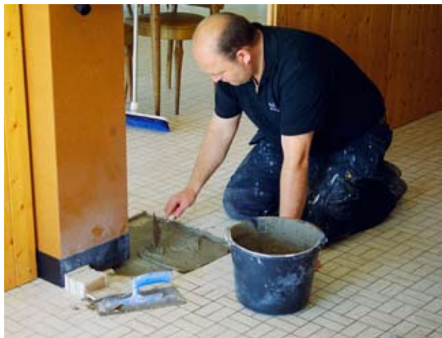
Aanpassing en herstelling van de vloer voor het plaatsen van de "nieuwe" winterafscherming: Michaël Müller
