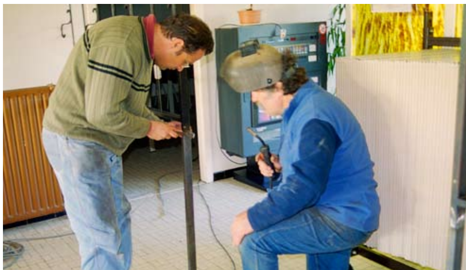
Bart Verhees en Broer Van der Hulst met laswerken bij de ingang
